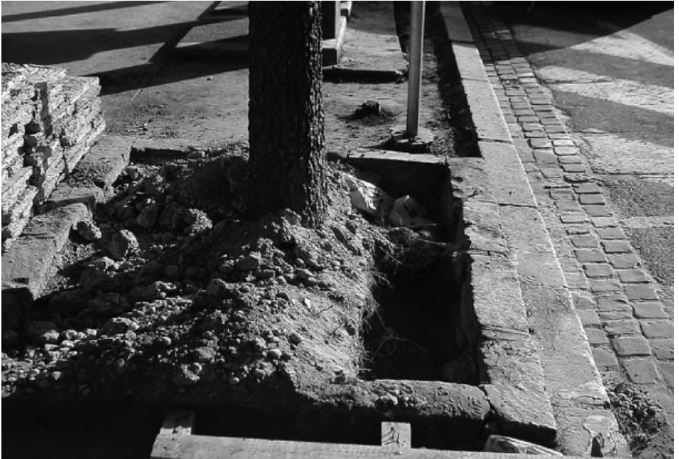
Obr.5: Výkop vedený priamo v koreňovej mise (foto: archív autorky)
